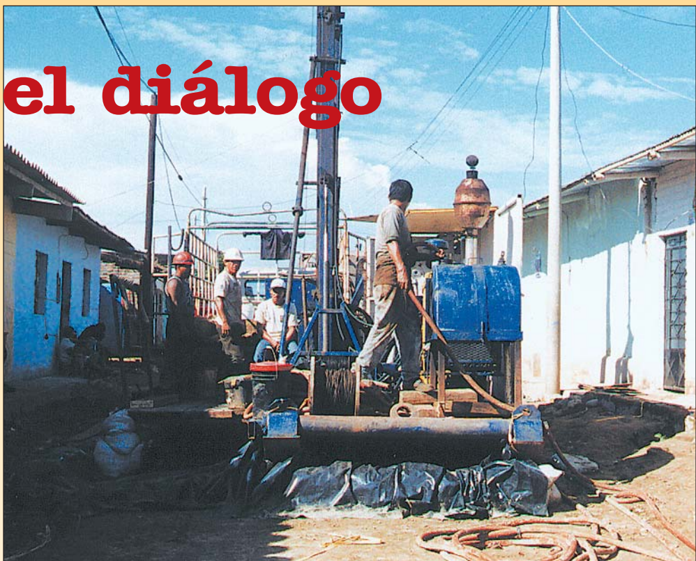
Máquinas perforadoras de la empresa minera en las calles de Tambogrande.
